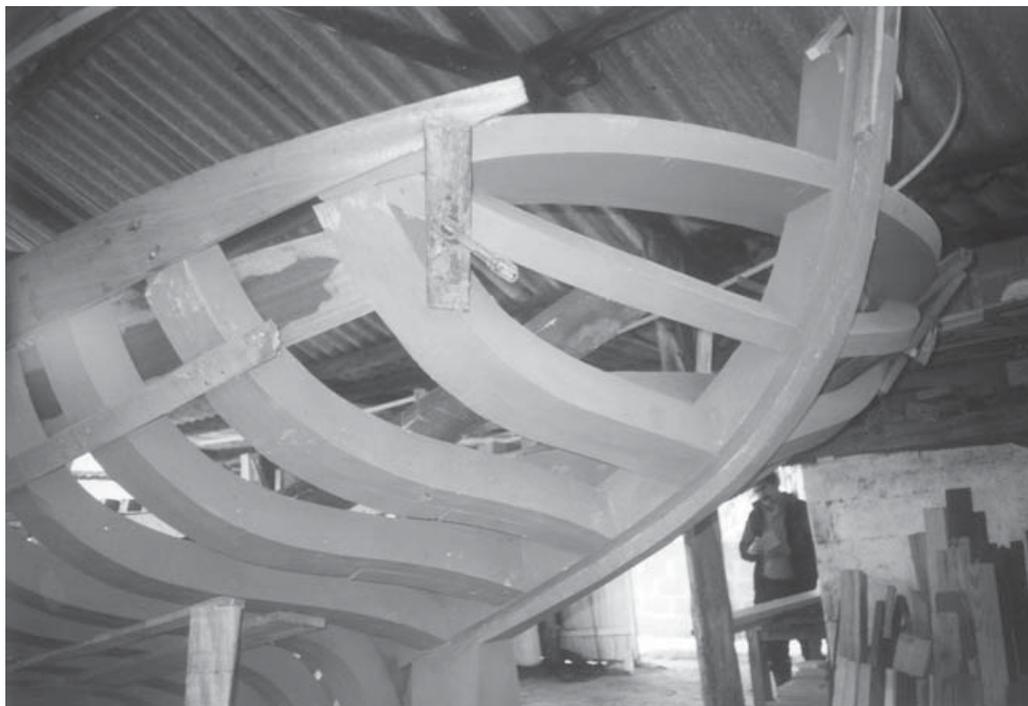
Figura 125.- Estructura de la popa de un barco de 10,70 metros de eslora total, en construcción en el astillero de César Loureiro Cintiana.
