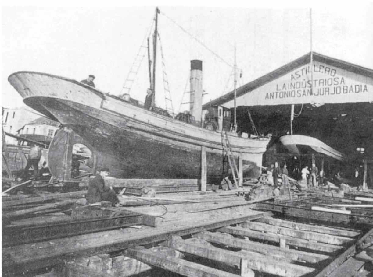
Figura 49.- Popa de *rabó de galo* de un pesquero a vapor construido hacia 1922
